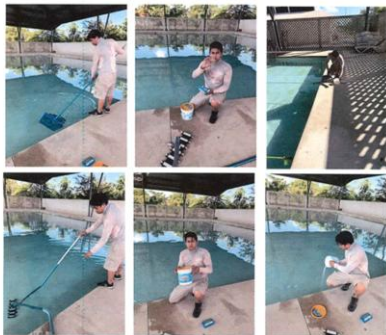
SEMANA DEL 9 AL 14 DEL MES DE FEBRERO SE REALIZO CANASTEO, MEDICION DE PARAMETROS, LIMPIEZA DE DESNATADORES, ASPIRADO Y APLICACION DE ACIDO CLORHIDRICO, DURANTE EL SERVICIO DE MANTENIMIENTO PREVENTIVO DE LA ALBERCA DE USOS MULTIPLES DEL MUNICIPIO DE TULUM DEL MES DE FEBRERO.
