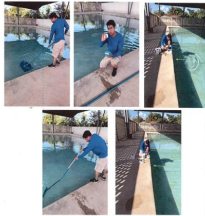
SEMANA DEL 9 AL 14 DEL MES DE FEBRERO SE REALIZO CANASTEO, MEDICION DE PARAMETROS, LIMPIEZA DE DESNATADORES, CEPILLADO, Y APLICACION DE CLORO EN TABLETAS, DURANTE EL SERVICIO DE MANTENIMIENTO PREVENTIVO DE LA ALBERCA DE USOS MULTIPLES DEL MUNICIPIO DE TULUM DEL MES DE FEBRERO.
