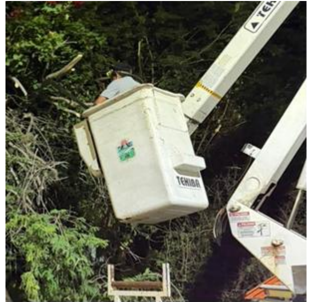
REPARACIÓN DE LINEAS POR CORTO CIRCUITO; C. 2 PTE ENTRE C. JUPITER NTE Y C. MEGANTE, COL. CENTRO.
