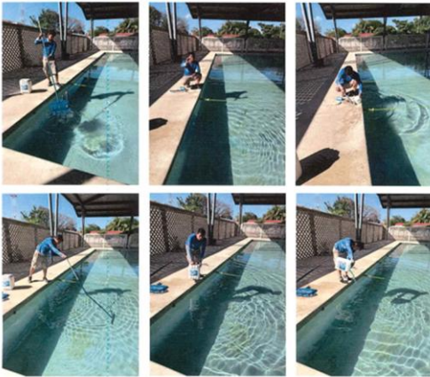
SEMANA DEL 2 AL 7 DEL MES DE FEBRERO SE REALIZO CANASTEO, MEDICION DE PARAMETROS, LIMPIEZA DE DESNATADORES, CEPILLADO Y APLICACIÓN DE ALGUCIDAS, DURANTE EL SERVICIO DE MANTENIMIENTO PREVENTIVO DE LA ALBERCA DE USOS MULTIPLES DEL MUNICIPIO DE TULUM DEL MES DE FEBRERO.
