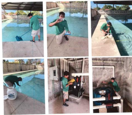
SEMANA DEL 2 AL 7 DEL MES DE FEBRERO SE REALIZO CANASTEO, MEDICIÓN DE PARAMETROS, LIMPIEZA DE DESNATADORES, APLICACIÓN DE CLORO EN POLVO, LIMPIEZA DE LA CANASTA DE LA BOMBA, REVISIÓN DE ARENA DE LOS FILTROS Y RETROLAVADO A FILTROS, DURANTE EL SERVICIO DE MANTENIMIENTO PREVENTIVO DE LA ALBERCA DE USOS MULTIPLES DEL MUNICIPIO DE TULUM DEL MES DE FEBRERO.
