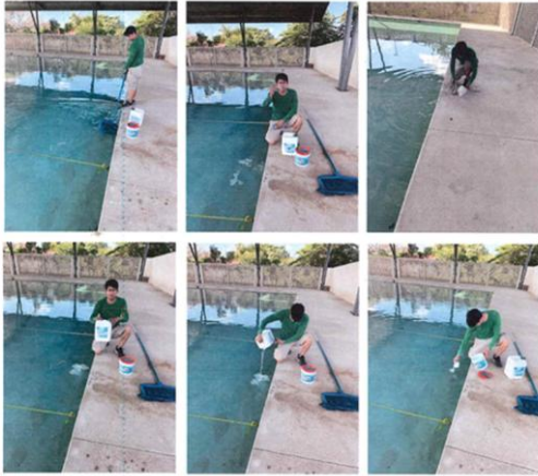
SEMANA DEL 2 AL 7 DEL MES DE FEBRERO SE REALIZO CANASTEO, MEDICION DE PARAMETROS, LIMPIEZA DE DESNATADORES, APLICACION DE FLOCULANTES Y APLICACION DE CLORO GRANULADO, DURANTE EL SERVICIO DE MANTENIMIENTO PREVENTIVO DE LA ALBERCA DE USOS MULTIPLES DEL MUNICIPIO DE TULUM DEL MES DE FEBRERO.
