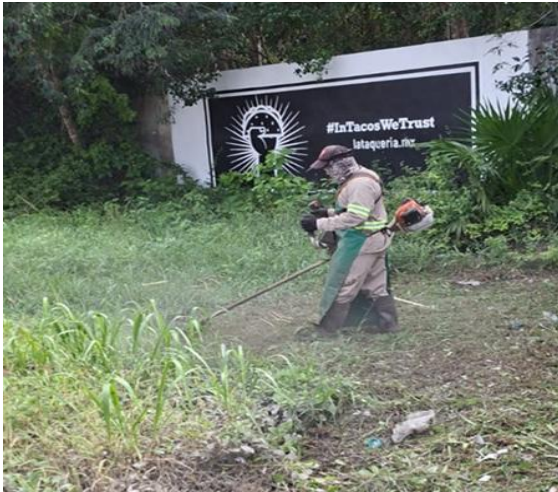
Poda de maleza. Av. Tulum oriente entre pintura premier Tulum hasta gasolinera mobil Tulum, ciclovía.
