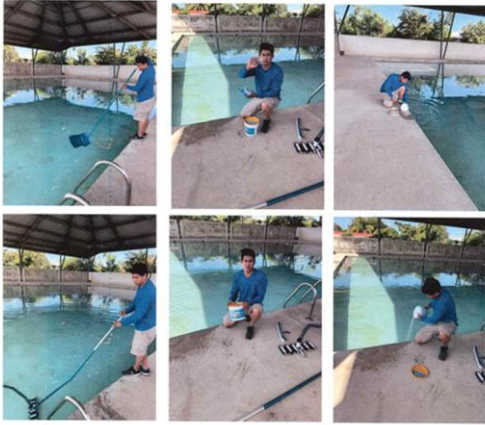
SEMANA DEL 2 AL 7 DEL MES DE FEBRERO SE REALIZO CANASTEO, MEDICIÓN DE PARAMETROS, LIMPIEZA DE DESNATADORES, ASPIRADO Y APLICACIÓN DE ACIDO CLORHIDRICO, DURANTE EL SERVICIO DE MANTENIMIENTO PREVENTIVO DE LA ALBERCA DE USOS MULTIPLES DEL MUNICIPIO DE TULUM DEL MES DE FEBRERO.
