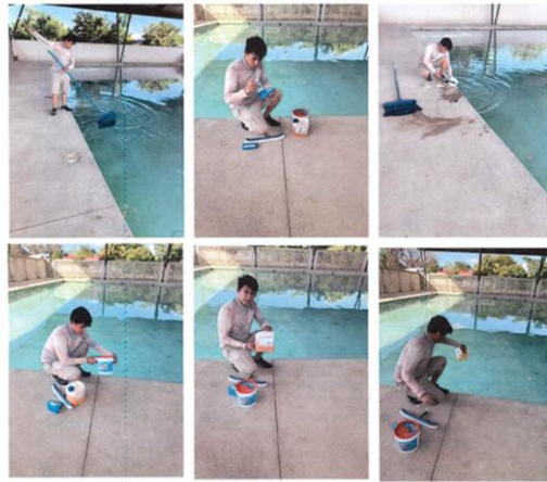
SEMANA DEL 2 AL 7 DEL MES DE FEBRERO SE REALIZO CANASTEO, MEDICION DE PARAMETROS CON EL EQUIPO COLOR QPRO7, LIMPIEZA DE DESNATADORES, APLICACION DE CLORO GRANULADO Y APLICACIÓN DE ABRILLANTADOR, DURANTE EL SERVICIO DE MANTENIMIENTO PREVENTIVO DE LA ALBERCA DE USOS MULTIPLES DEL MUNICIPIO DE TULUM DEL MES DE FEBRERO.
