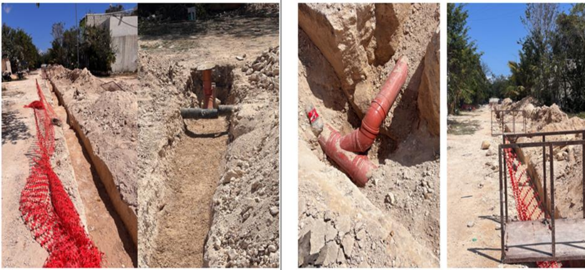
CONSTRUCCION DE LA RED DE DRENAJE SANITARIO DE LA COLONIA YAAX TULUM, 2DA ETAPA
