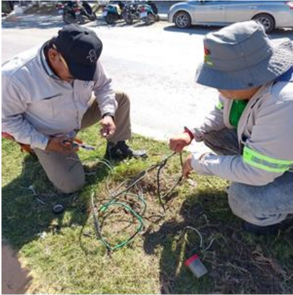
REHABILITACIÓN DE LINEAS SUBTERRANEAS POR CORTO CIRCUITO; AV. TULUM ENTRE AV. SATÉLITE Y C. ACUARIO, COL. CENTRO.
