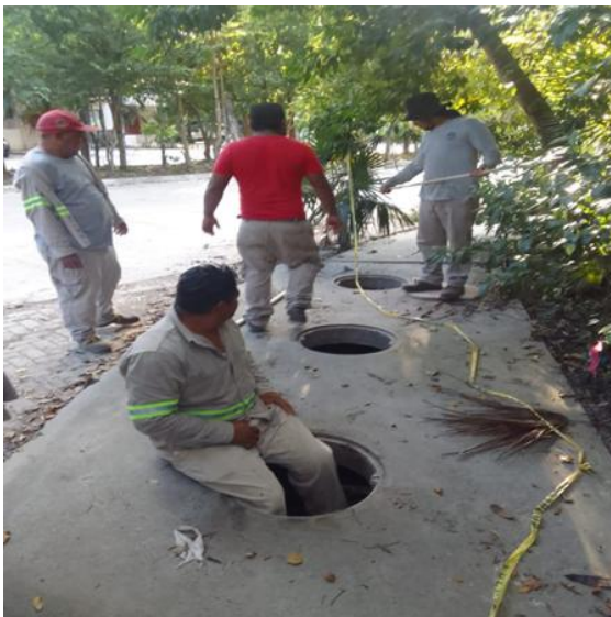
Limpieza de pozos. Av. balam dzancab entre calle kinich-na; fraccionamiento aldea zama.
